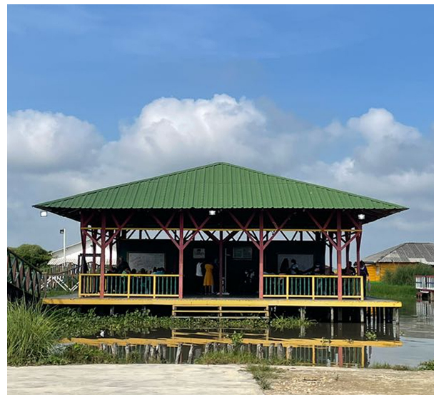
Figura 1. Centro de encuentro Nueva Venecia.
